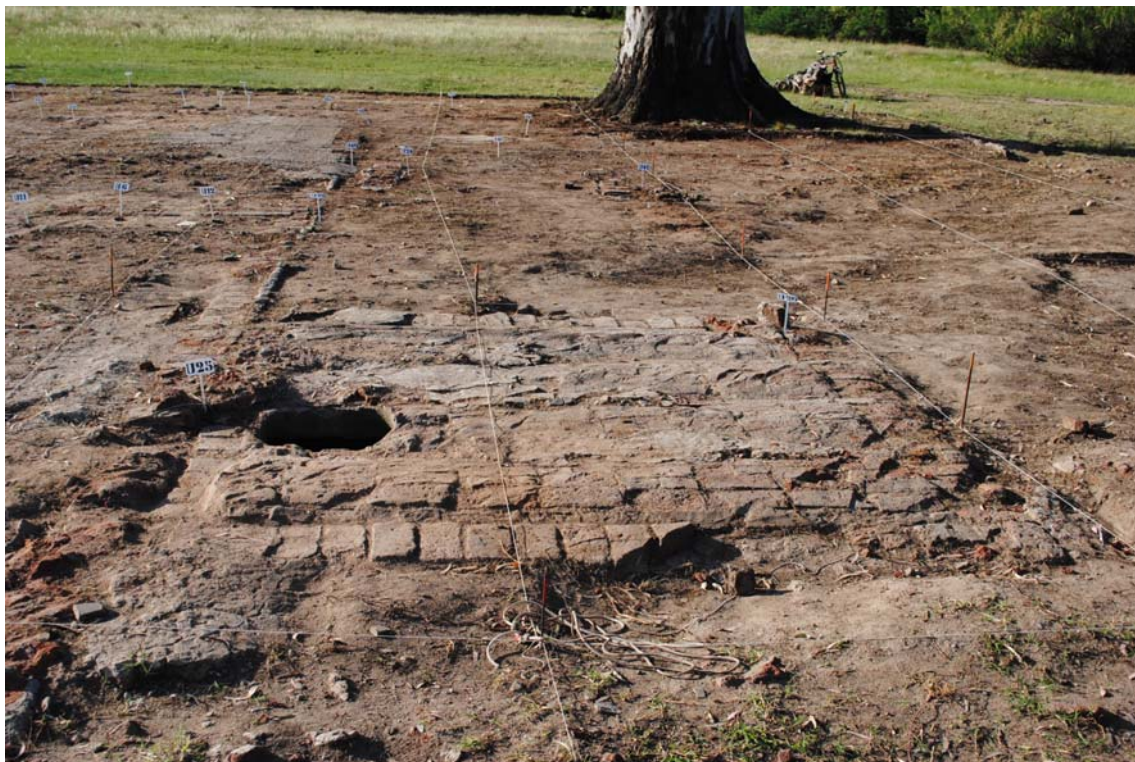
Foto 3.3.4.a. Vista de la cisterna, correspondiente a la bovedilla que conforma la cubierta.
