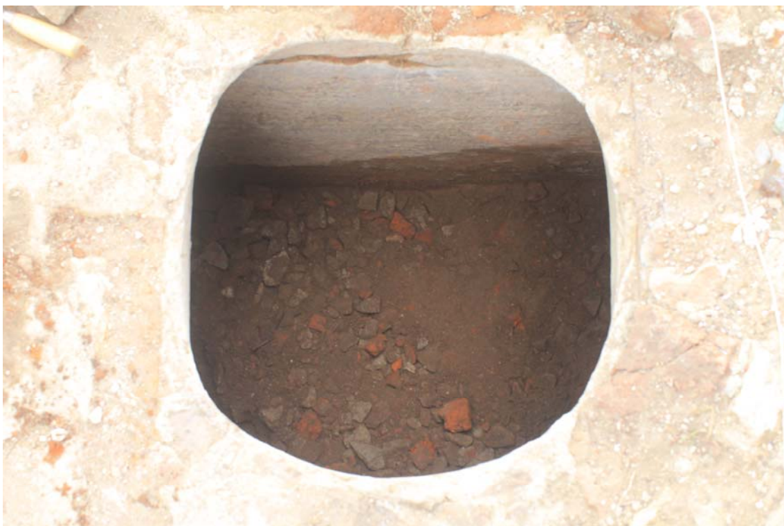
Foto 3.3.4.b. Vista de la cisterna, correspondiente a la boca de acceso.
