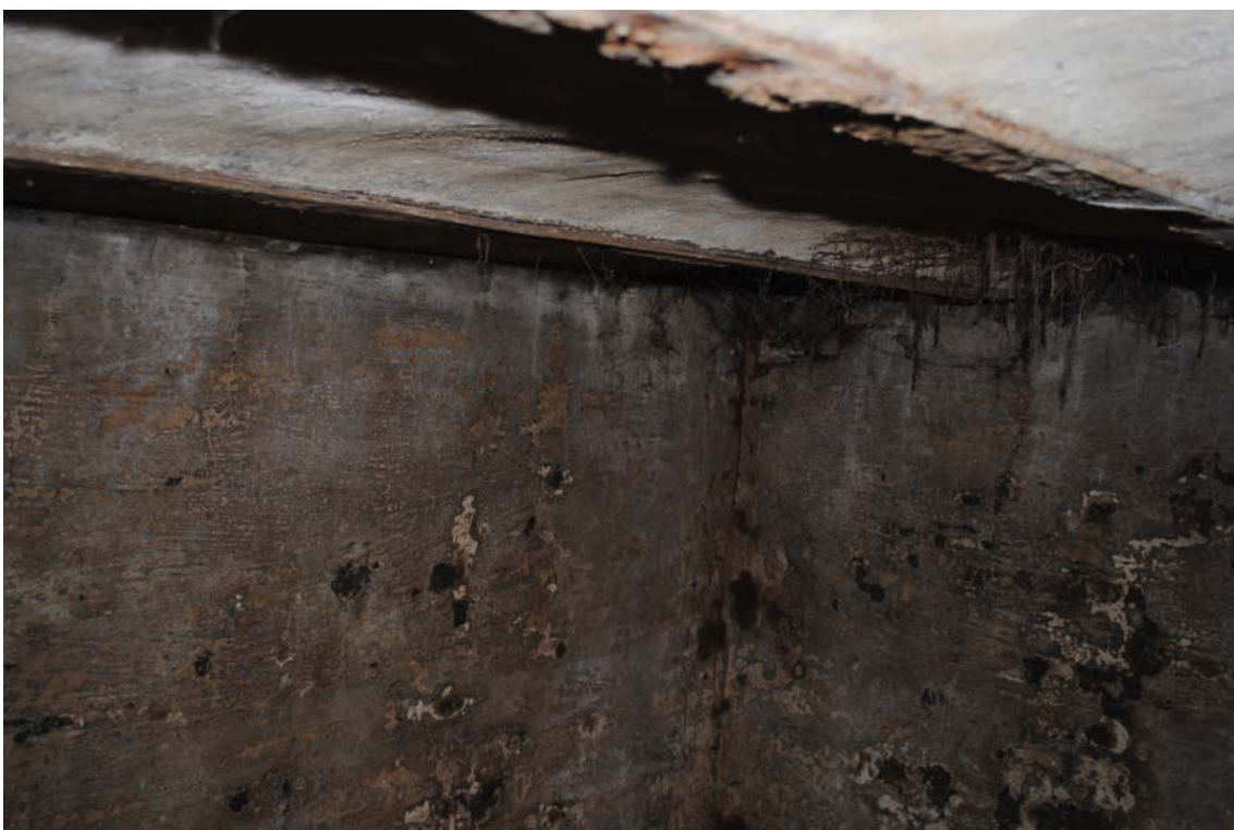
Foto 3.3.4.c. Vista parcial del interior de la cisterna.
