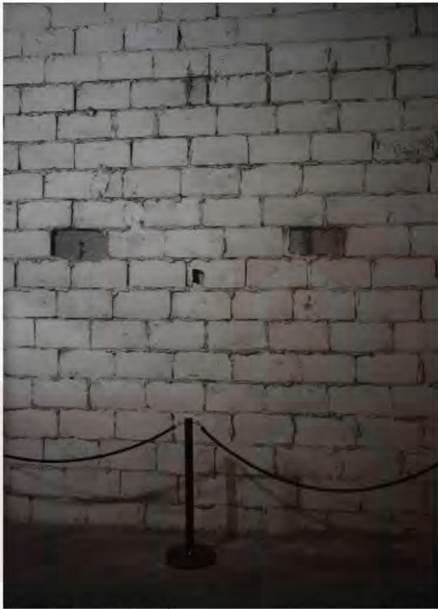
[Foto 15: Espacio concentracionario de la Planta Alta; detalle a orificios en el muro. Fotografía de Manuel Cardoso Sánchez]
