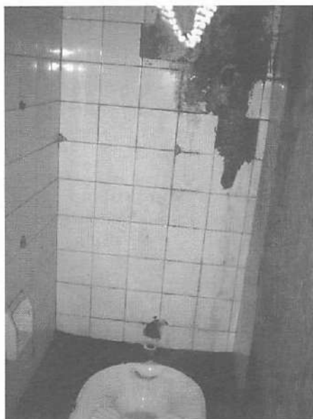
Baño de Monte Grande, inspección ocular. Archivo de Memoria Abierta.
