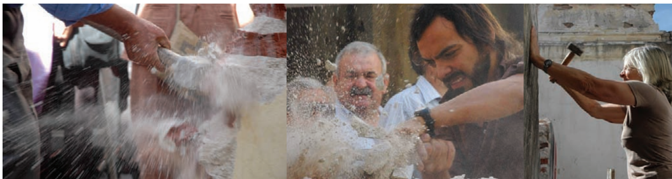
Derribando Olvidos. A 31 años del golpe se derrumbó un muro construido en los 80' que dividía un viejo patio y dificultaba a los sobrevivientes el reconocimiento del lugar.
